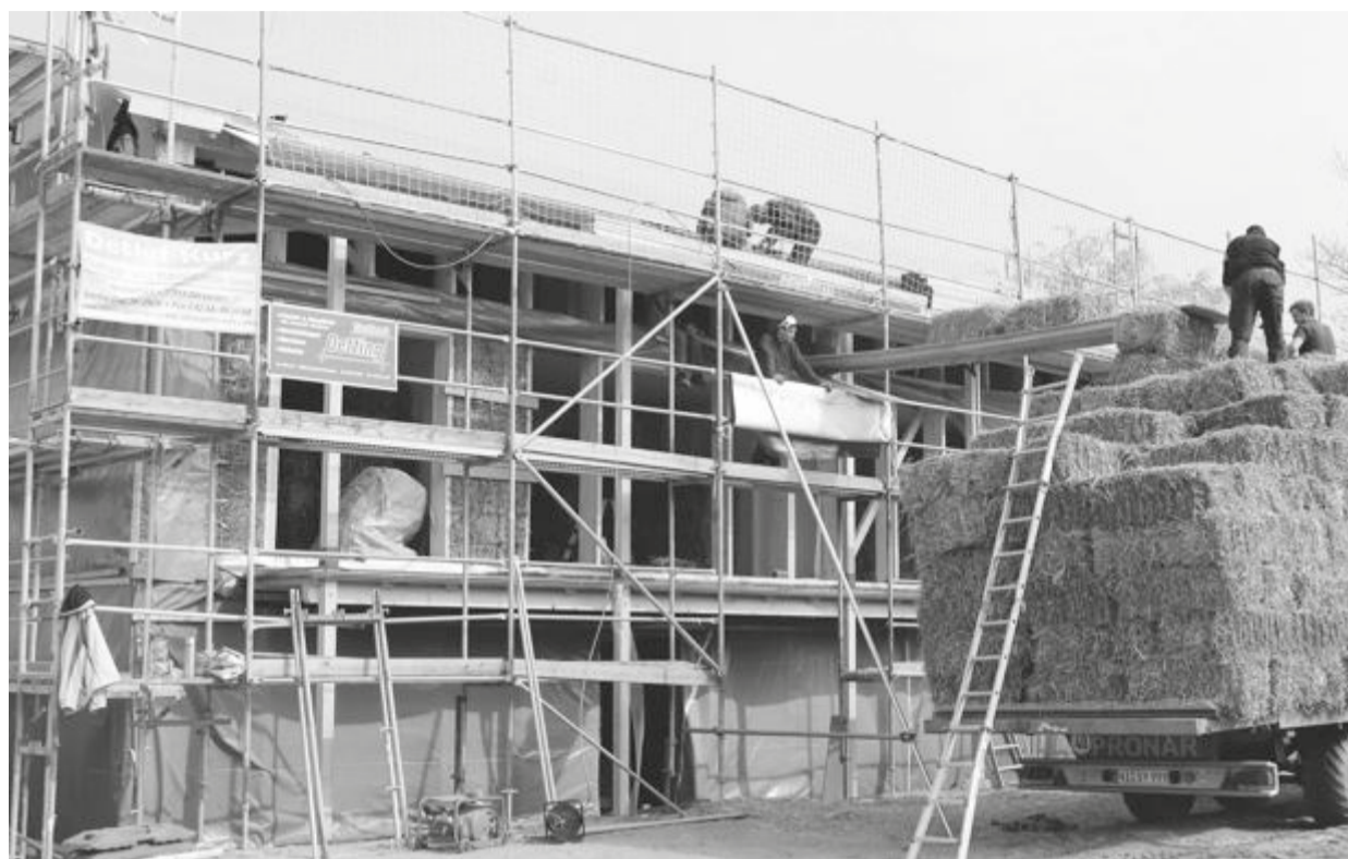
▲ Geringe Transportkosten: Anlieferung der Baustrohbälle, die zur Dämmung der Außenwand zwischen die tragende Holzkonstruktion eingefügt werden
